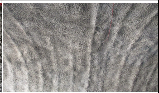
매봉터널 슛크리트 시공 상태(서울방향)
