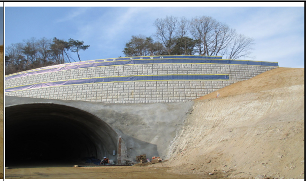
매봉터널 종점부 갱구부 시공 상태 (서울방향)
