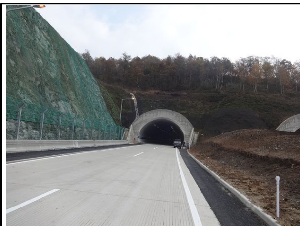
갱문 시점부 전경
