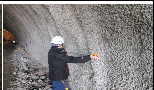
매봉터널 지보패턴간격 측정(서울방향)
