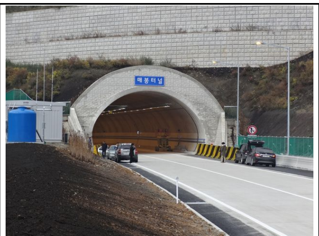
갱문 종점부 전경
