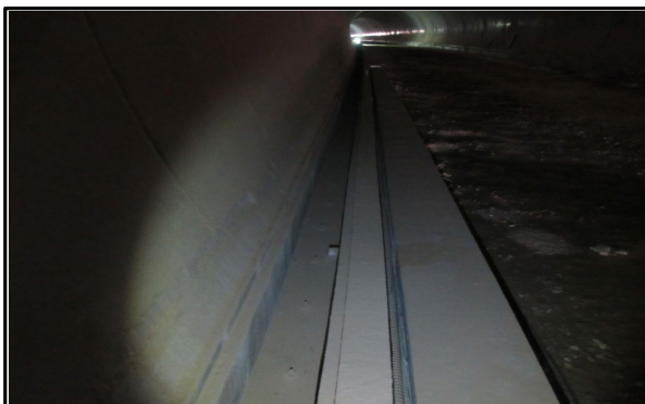
매봉터널 공동구 시공 상태 점검(서울방향)
