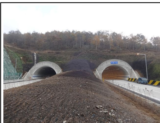
시점측 터널부사면 전경
