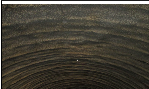
매봉터널 슛크리트 시공 상태(서울방향)
