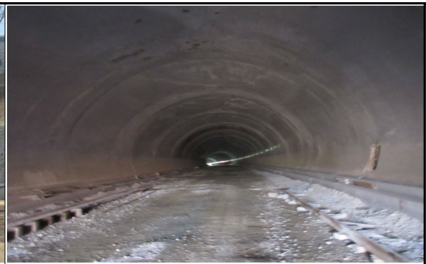
매봉터널 내부 전경(서울방향)
