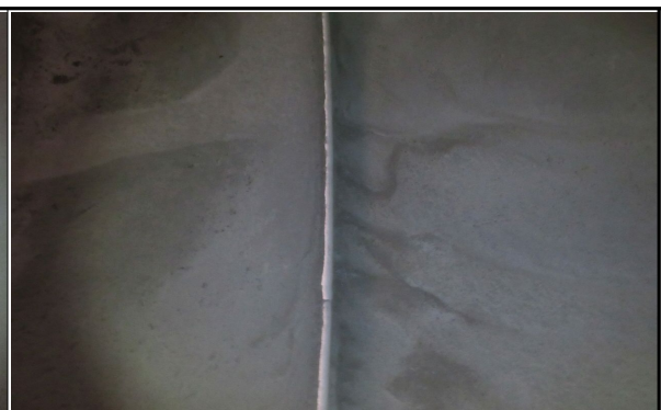
매봉터널 JOINT 시공 상태 점검(서울방향)
