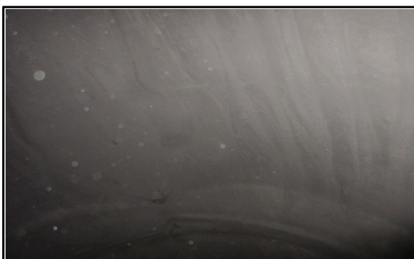
매봉터널 라이닝 천정부 시공 상태 점검(서울방향)
