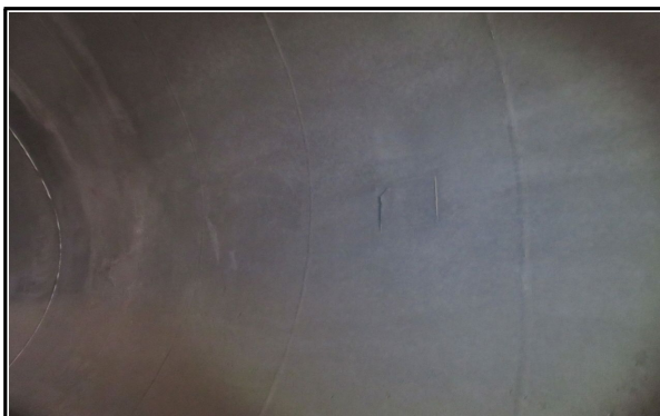
매봉터널 라이닝 시공 상태 점검(서울방향)
