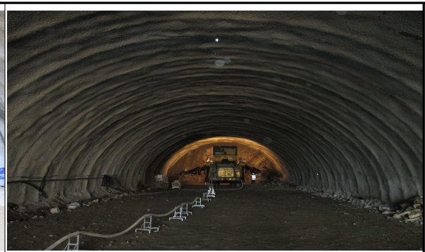
매봉터널 내부 시공 상태 점검(서울방향)
