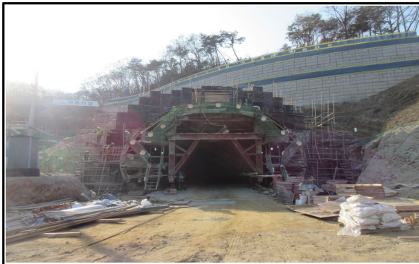
매봉터널 시공 전경
