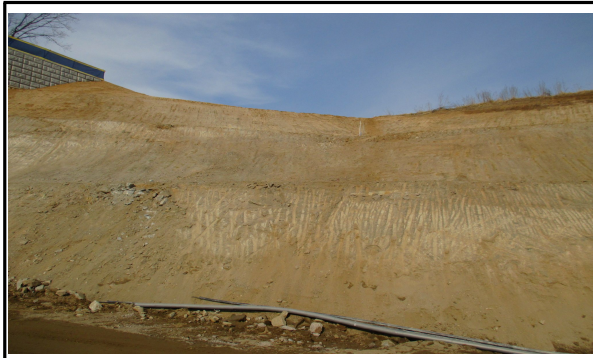
매봉터널 종점부 법면 시공 상태 (서울방향)
