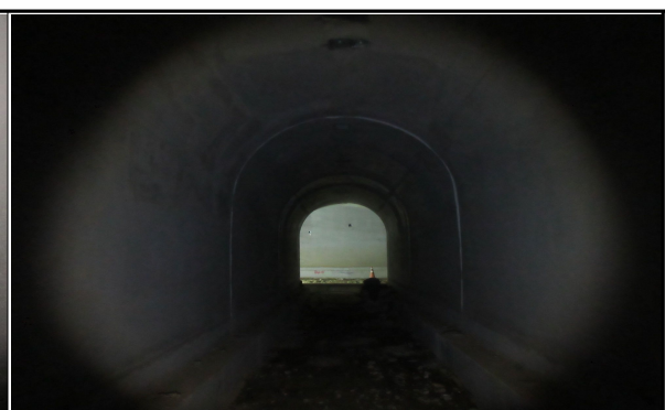
매봉터널 횡갱 공동구 균열 보수
