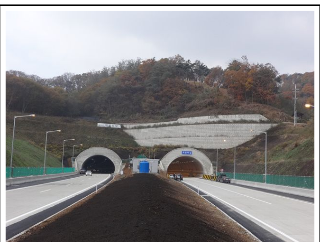
종점측 터널부사면 전경
