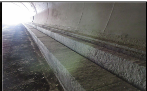
매봉터널 공동구 시공 상태 점검(서울방향)
