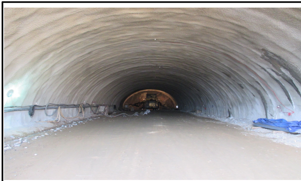
매봉터널 내부 전경(서울방향)
